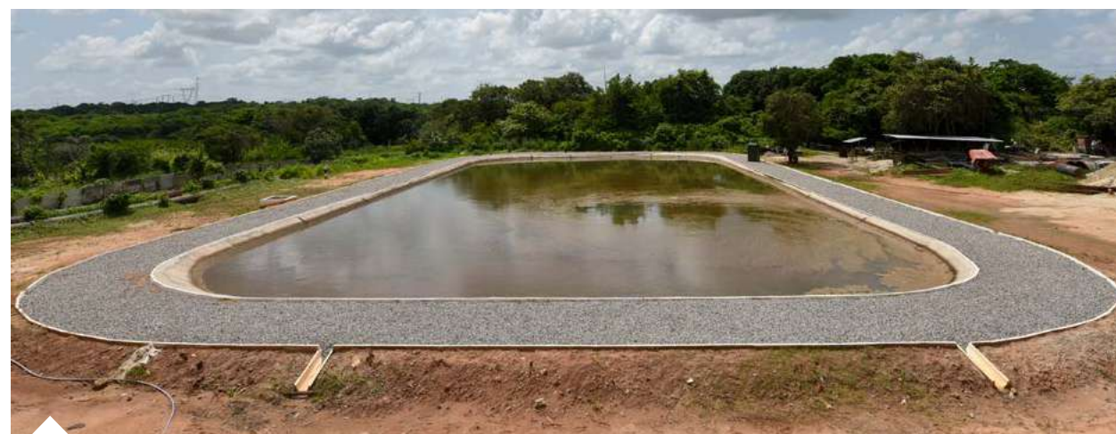
Tanque de Equalização, que tem a função de armazenar a água das lavagens dos filtros e permitir recirculação contínua com uma vazão menor e aumentar o volume recirculado
