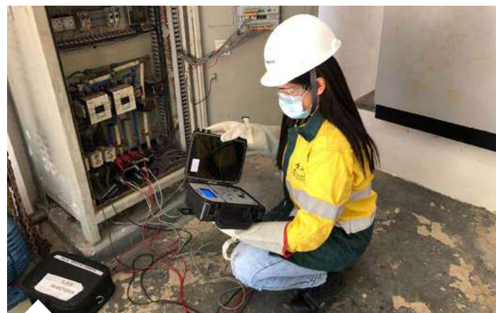
Colaboradora realizando procedimento de análise de qualidade de energia em uma elevatória de esgoto da cidade de Paracuru
