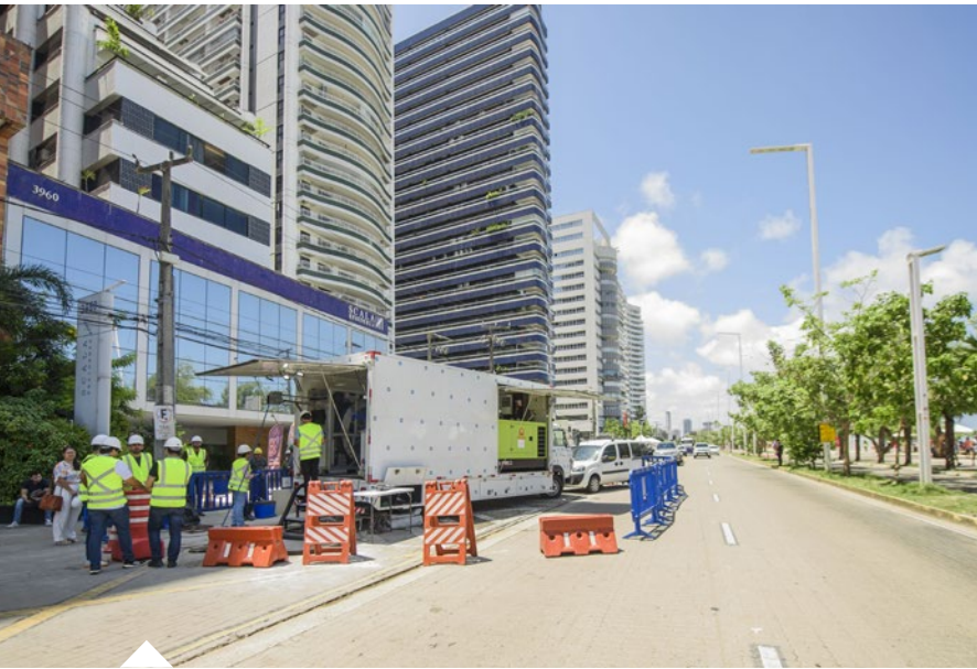
A obra de substituição do Interceptor Leste, em Fortaleza, foi uma das pioneiras do método não destrutivo.
