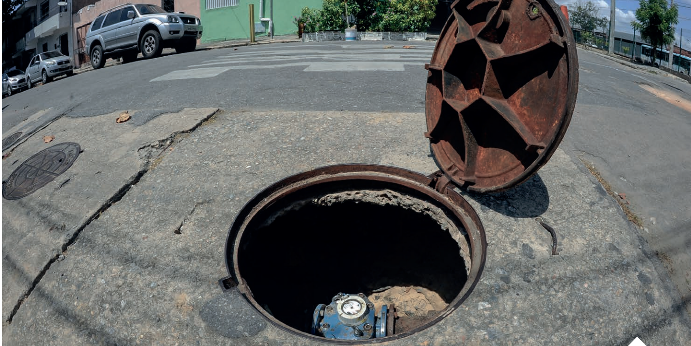
Macromedidor instalado na entrada principal do setor hidráulico permite melhor gestão da distribuição da água
