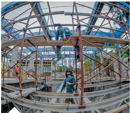
Obra de substituição da caixa de remoção de areia da EPC
