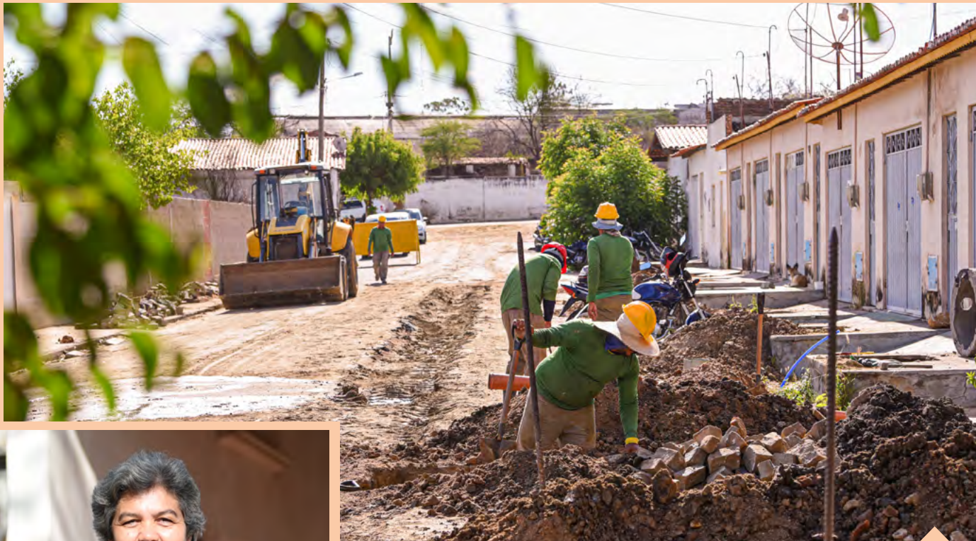
Obra de esgotamento sanitário da Cagece que beneficiará cerca de 1.500 famílias em seis bairros de Tauá
